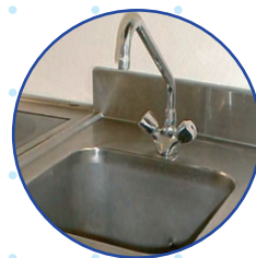
Evier alimenté en eau potable
